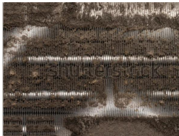
Slika 66. Nečiste površine isparivača/kondenzatora
