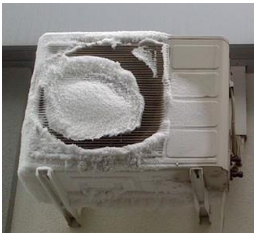
Slika 36. Inje na orebrenim sekcijama isparivača
