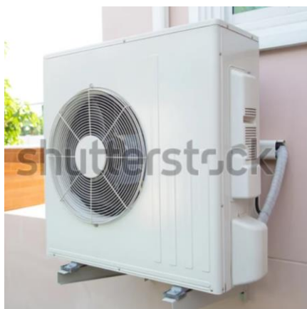
Slika 42. Konzolna ugradnja vanjske jedinice dizalice topline na konzolni zidni čelični nosač
