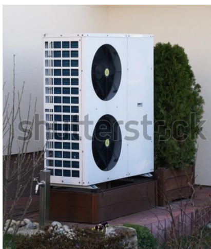
Slika 41. Horizontalna ugradnja vanjske jedinice dizalice topline
