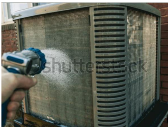
Slika 65. Prikaz čišćenja isparivačkih/kondenzatorskih sekcija
