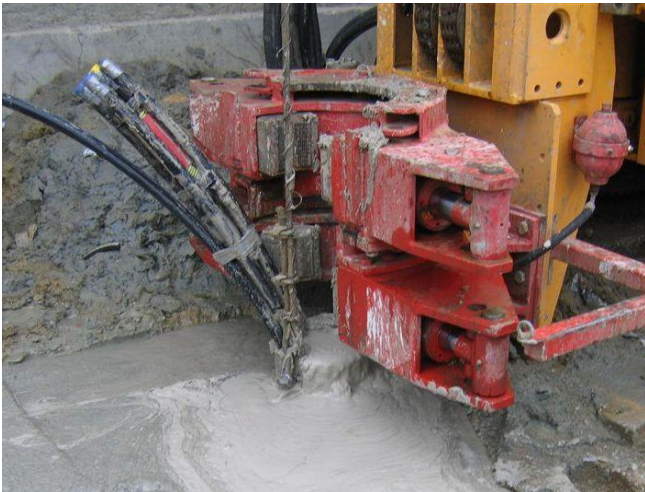
Slika 55. Ispuna bušotine
