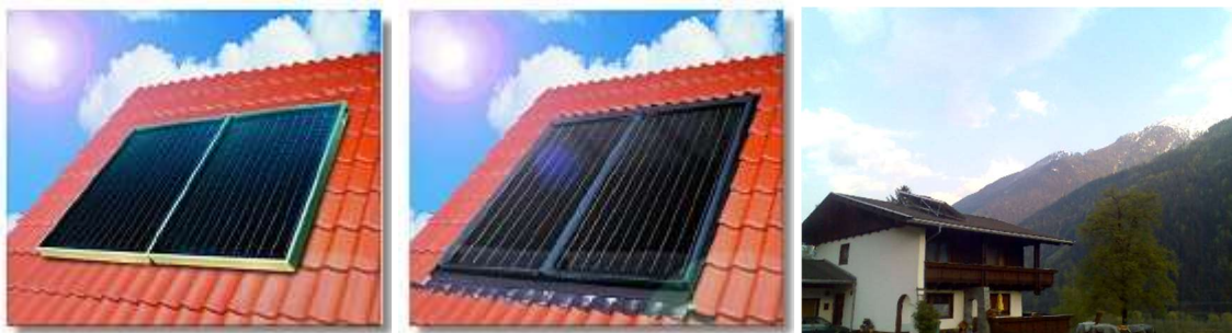
Slika 40. a) kolektor montiran na krov, b) kolektor montiran kao dio krova c) kolektori montirani na nosače (kosi krovovi koji znatno odstupaju od smjera juga) [12]
